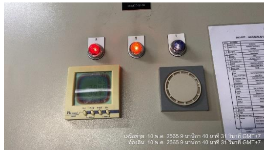
รูปที่ 6 มิเตอร์ไฟฟ้าสำหรับระบบบำบัดน้ำเสีย
