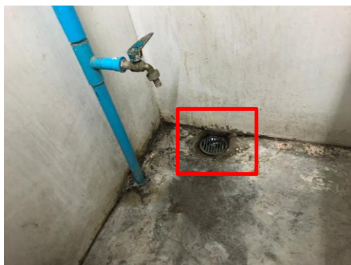
รูปที่ 16 ท่อรวบรวมน้ำเสียภายในห้องพัสดุฝอย
