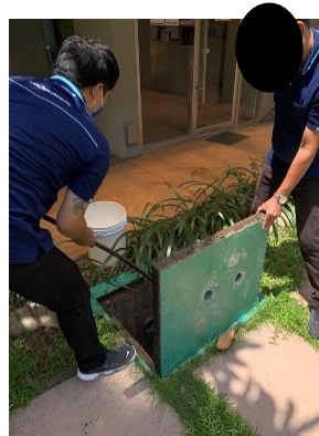
รูปที่ 53 ขุดลอกตะกอนในรางระบายรอบโครงการ
