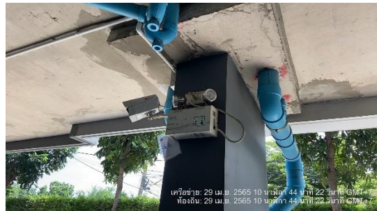
รูปที่ 23 ไฟส่องสว่างฉุกเฉิน
