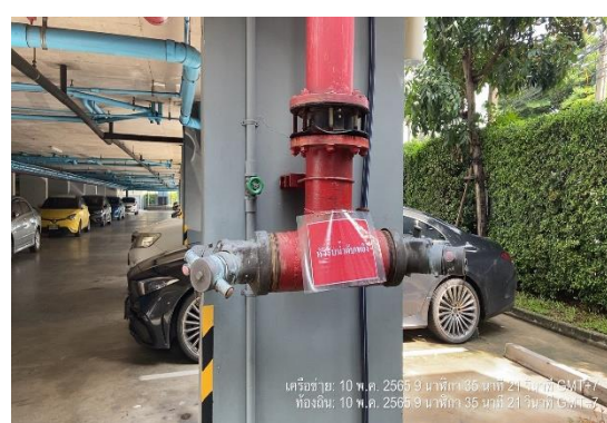
รูปที่ 21 หัวรับน้ำดับเพลิงภายนอกอาคาร
