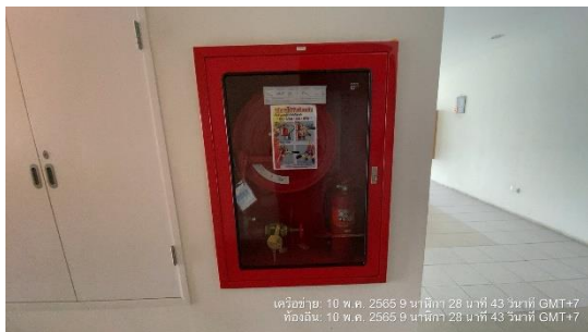
รูปที่ 19 ตู้เก็บสายฉีดน้ำดับเพลิง
