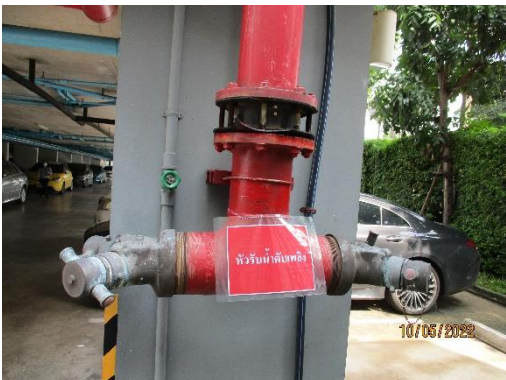
รูปที่ 21 หัวรับน้ำดับเพลิงภายนอกอาคาร
